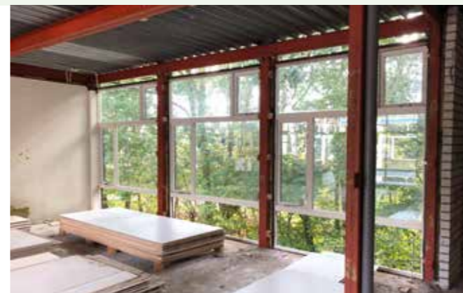
Het dak van de school is een combinatie van staal (HWC met stalen liggers), isolatie en bitumineuze dakbedekking.
