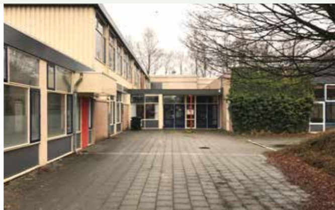
Het schoolgebouw is in 1978 opgeleverd en sindsdien regelmatig verbouwd.
